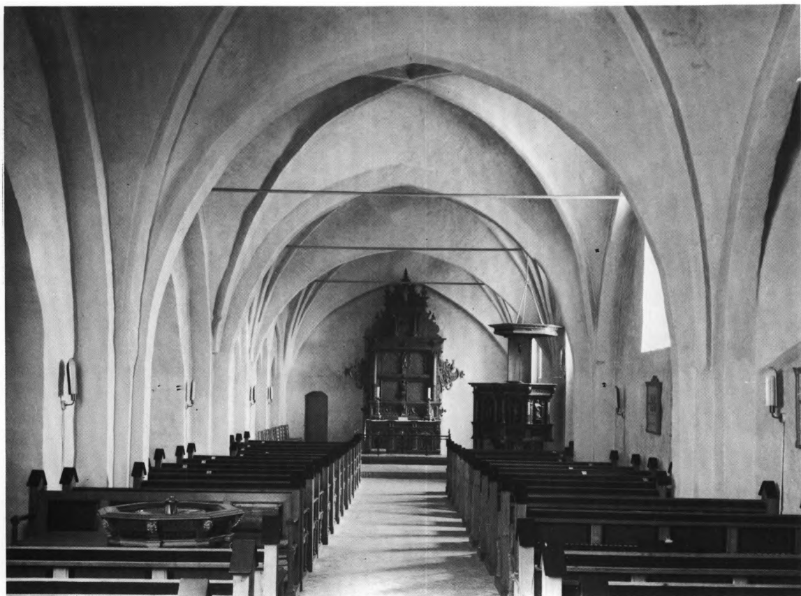
Fig. 9. Indre, set mod øst. NE fot. 1978. - Interior to the east.
